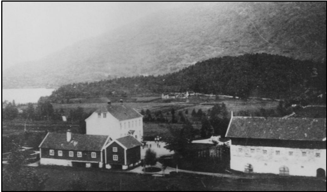
Skulen på Mo, med nye bygg frå 1864 og 1865
